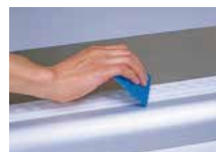
④ スクイジー、ローラー等でリベット周りの空気を押し出しながら圧着します。
