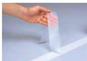
② テープを十分に圧着した後で、アイオノマーフィルム上の保護フィルムを剥がします。
